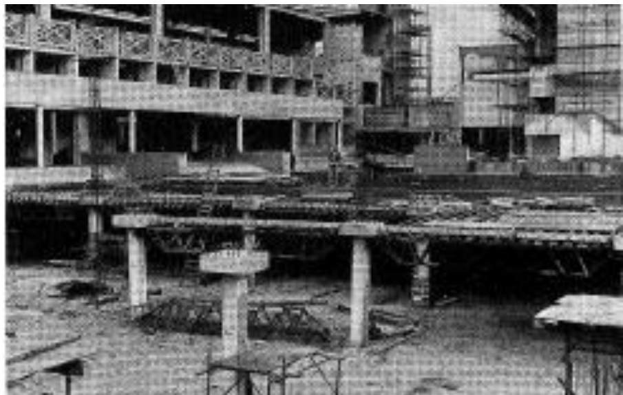
40 Onderheide binnenplein in aanbouw
