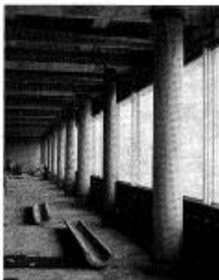
10 Speciale constructie van de voet voor de onderste kolom
