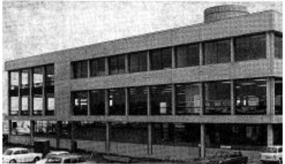
20 Dezelfde gevel na voltooiing
